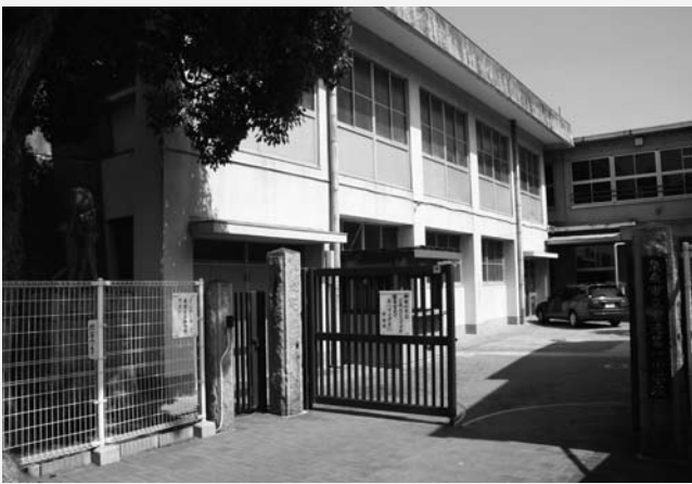
鳴滝第一小学校
