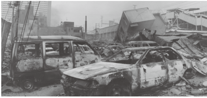
阪神淡路大震災の被災状況：写真提供 神戸市
