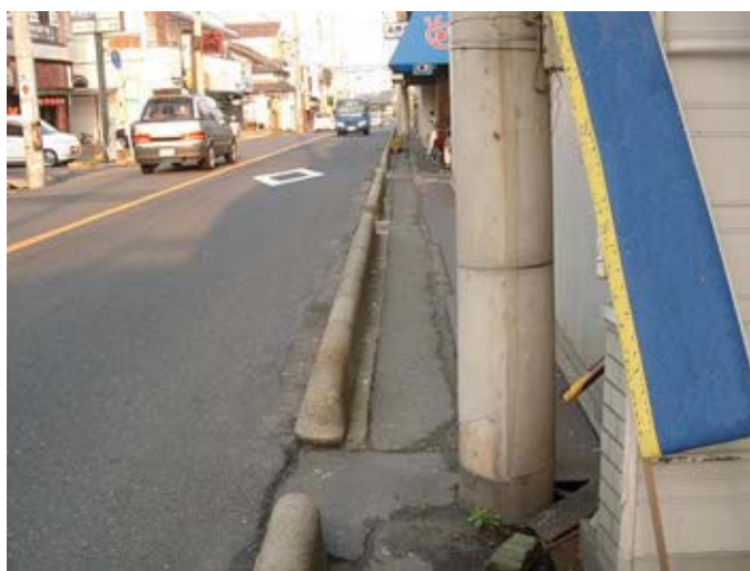
↑電柱、看板により狭い歩道が ますます狭くなっている
