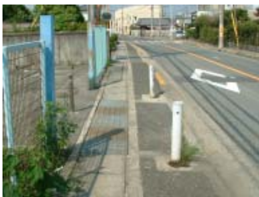
※1 側溝の蓋の改修
