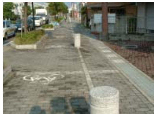
※2 車止め、舗装状況
