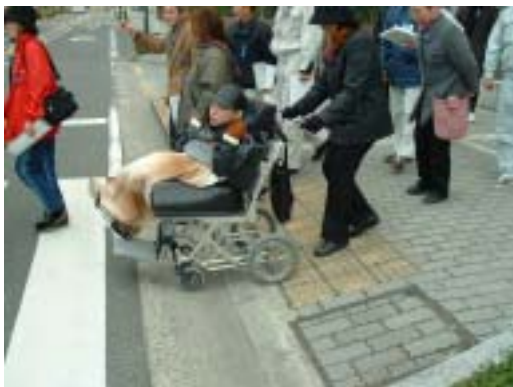
※1 歩道の切下げ状況
