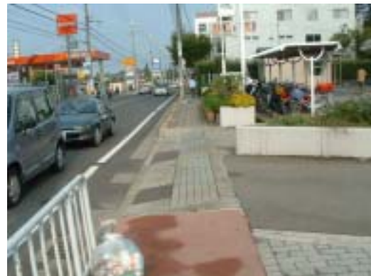
※2 横断勾配、側溝の蓋の改修
