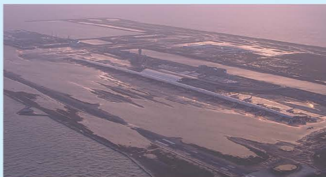
冠水した関西国際空港と連絡橋に衝突した船舶:台風21号(平成30年9月) 写真提供:国土交通省近畿地方整備局 ※参考 https://www.kkr.mlit.go.jp/bousai/saigairairurari/index.php
