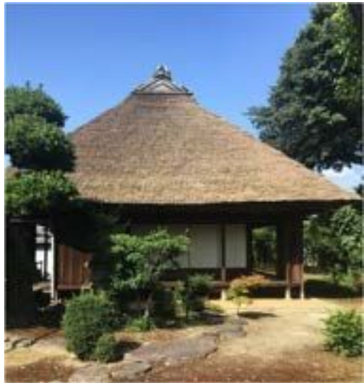
R6-4 降井家住宅（重要文化財の書院）（熊取町）
