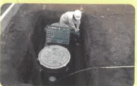
No.9 埋戻し工事[水締め・つき固め]
