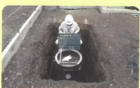
No.8 据付け工事[浄化槽本体の水平確認] ※浄化槽設備士
