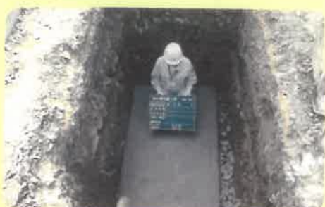
No.4 基礎工事[捨てコンクリート工事]
