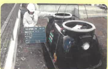
No.7 据付け工事[浄化槽本体の確認]
