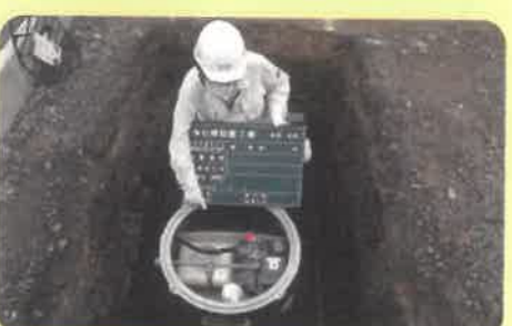
No.10 浄化槽本体[内部部品取付け状況・漏水検査] ※浄化槽設備士
