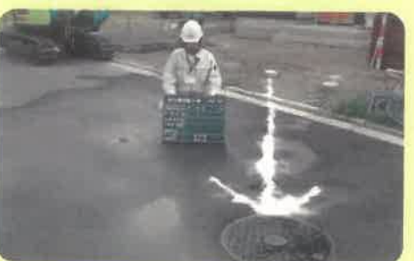
No.12 配管工事[放流管・放流先]
