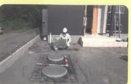
その他特殊な工事・上部配筋状況 (駐車場仕様)
