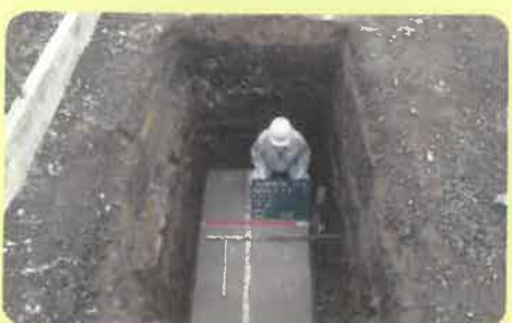
No.6 基礎工事[コンクリート打設]
