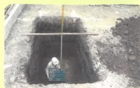
No.2 土工事[根切り工事]
