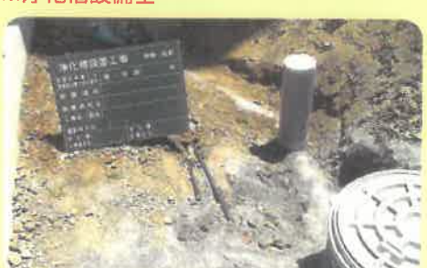
No.11 配管工事[流入管]
