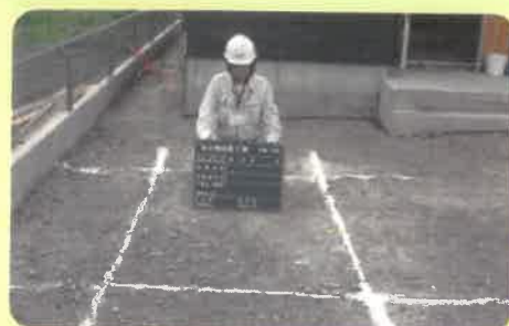
No.1 浄化槽設置位置決定[地縄張り] ※浄化槽設備士
