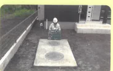
No.13 仕上げ工事[上部スラブコンクリート打設] No.14 ブロワ据付け工事[ブロワ] No.15 完了工事[完了状況の確認]
