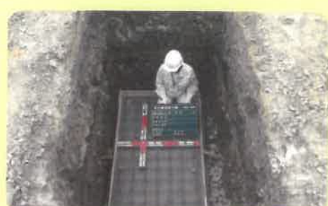
No.5 基礎工事[型枠・配筋工事]
