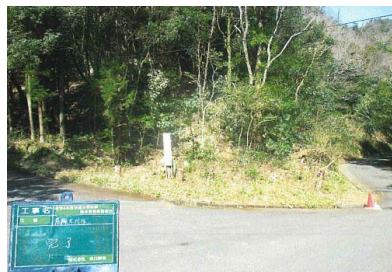
（事業1：撤去後の状況）
