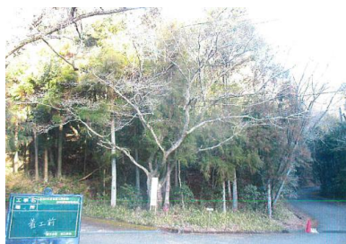
（事業1：撤去前の状況）
