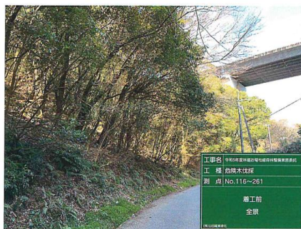
（事業1：撤去前の状況）
