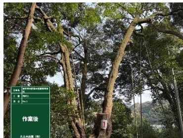
（事業1：撤去後の状況）
