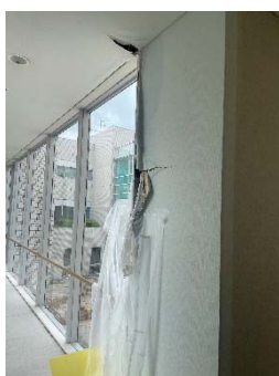
○総合福祉センター内全館の雨漏り状況（令和４年８月１７日監査人撮影）
