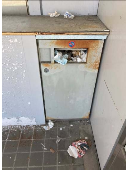
○ATM建物（令和4年7月28日監査人撮影）
