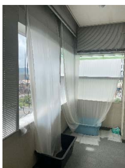
○総合福祉センター内全館の雨漏り状況（令和４年８月１７日監査人撮影）
