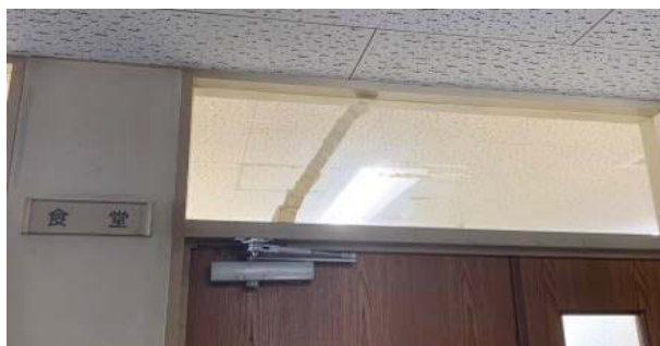
○清掃庁舎2階の食堂入口上部窓（令和4年8月10日監査人撮影）
