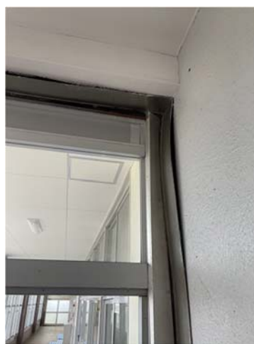
A棟B棟連結部分
