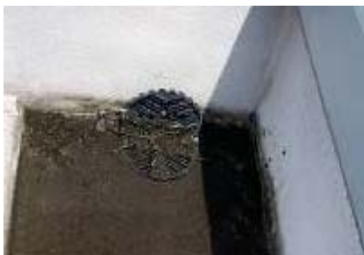
○保健センター屋上雨どい付近（令和4年8月22日監査人撮影）
