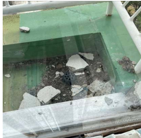
○新家小学校教室ベランダ部の天井剥離（左）とベランダに落下した剥離したコンクリート片（右）（令和4年8月24日監査人撮影）
