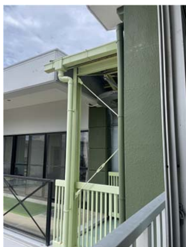
2階屋根の雨どい
