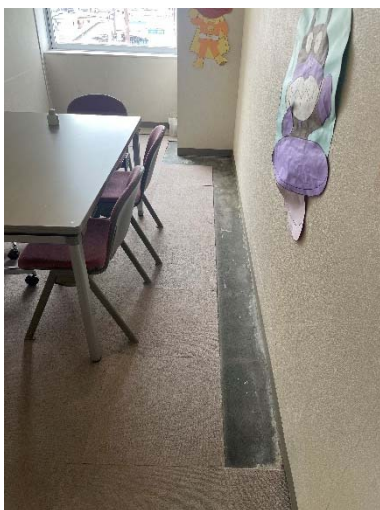
○総合福祉センター内床下からの雨漏り（令和4年8月17日監査人撮影）
