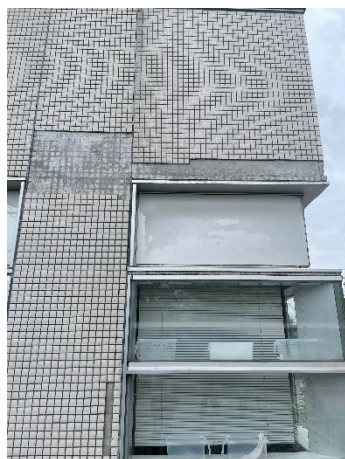
○総合福祉センタータイル剥げ、塗装剥げ（令和4年8月17日監査人撮影）
