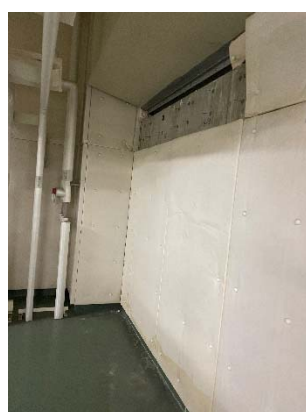
○総合福祉センター内機械室雨漏り（令和４年８月１７日監査人撮影）
