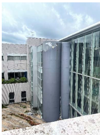
○総合福祉センタータイル剥げ、塗装剥げ（令和4年8月17日監査人撮影）
