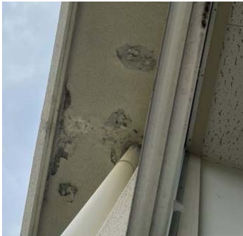
○新家小学校教室ベランダ部の天井剥離（左）とベランダに落下した剥離したコンクリート片（右）（令和4年8月24日監査人撮影）
