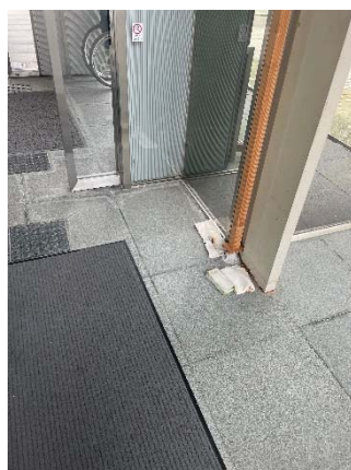
○総合福祉センター内エレベーター横、玄関雨漏り（令和４年８月１７日監査人撮影）
