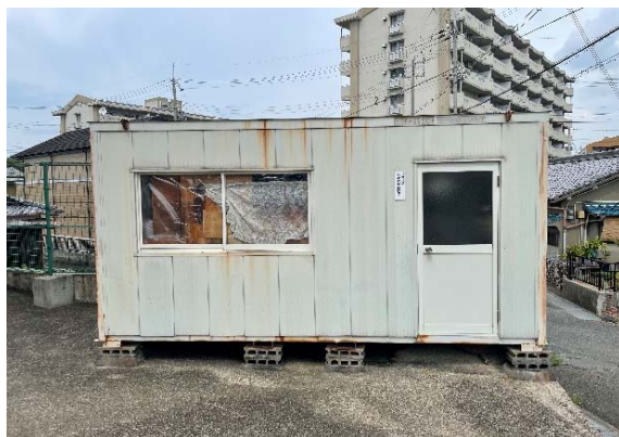
○樽井老人集会場敷地内のプレハブ倉庫の一つ（令和 4 年 8 月 17 日監査人撮影）
