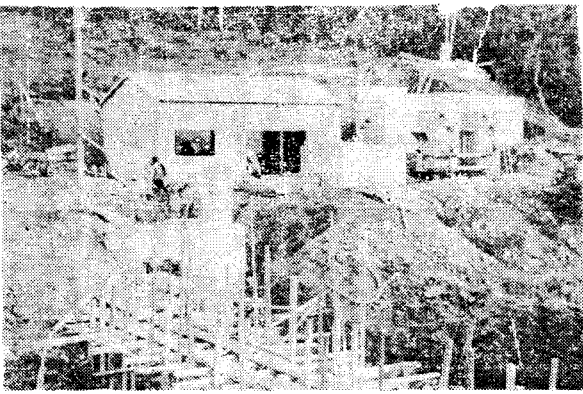
(写真は完成近い水源地工事)
