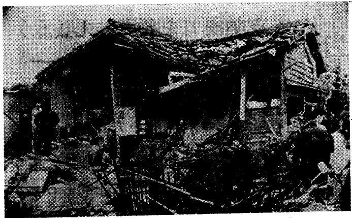
管内で発生した非難なプロパンガス現場
