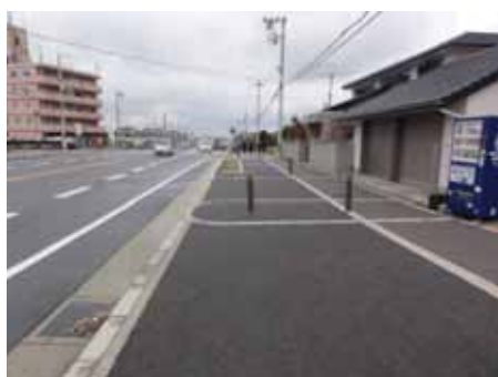
歩道バリアフリー整備済み区間
