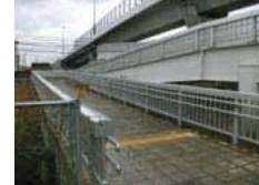
跨線橋のスロープが長いので、イオンへ行く時地元の人々は踏切へ迂回している。
