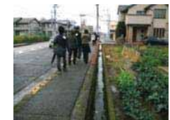
未拡幅区間は転落防止柵が必要
