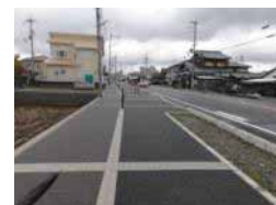
傾斜が長く続く歩道
