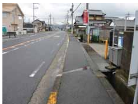
歩道バリアフリー未整備区間
