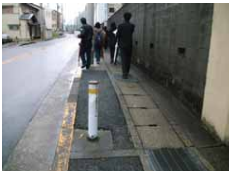
歩道の車止めや電柱が障害となっている
