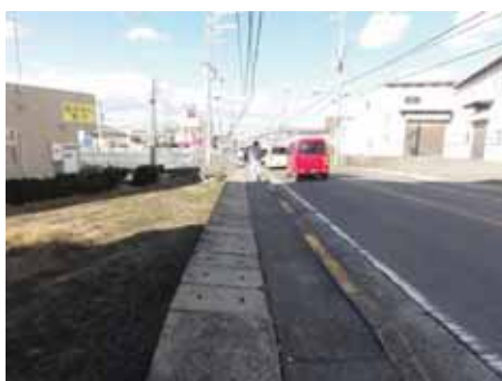
転落防止柵が設置されていない箇所
