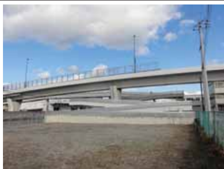
南海跨線橋のスロープ
