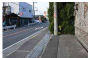
植え込みが歩道にはみ出している
