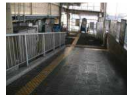
スロープ、傾斜がきつい
