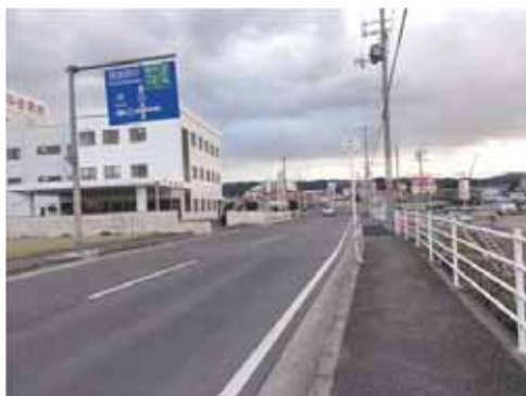
経路③ 歩道が途切れている
