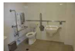
身障者用トイレが設置されている
