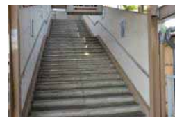
階段に通行区分がない
