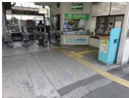
新家駅改札前誘導ブロック
