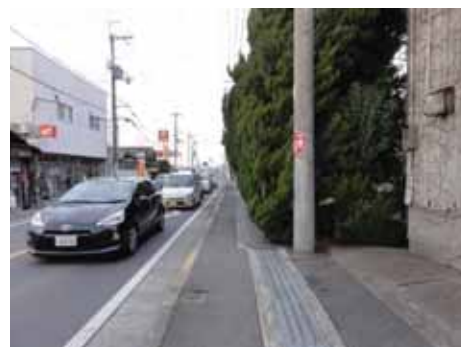
植栽がはみ出し狭くなった歩道
