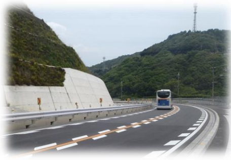
(都)泉南岩出線（2車線暫定供用中）
