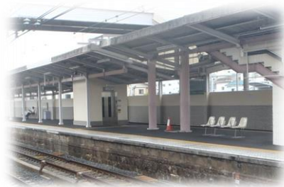
樽井駅（エレベーター設置）
