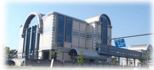
中部ポンプ場（雨水ポンプ施設）
