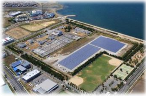
南部水みらいセンター（下水処理場）
