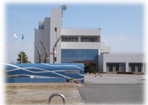
南部水みらいセンター（下水処理場）
