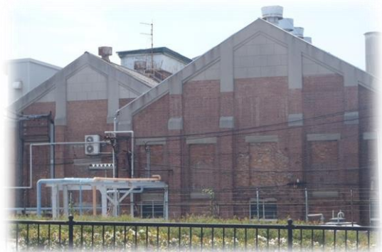
レンガ造の工場
