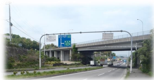
(都)泉南岩出線 泉南 IC 付近
