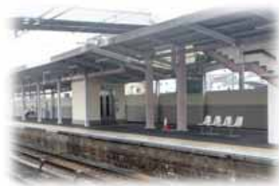
樽井駅（エレベーター設置）
