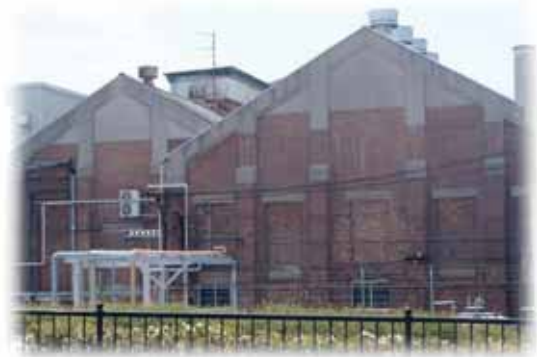
レンガ造の工場
