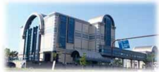
中部ポンプ場（雨水ポンプ施設）
