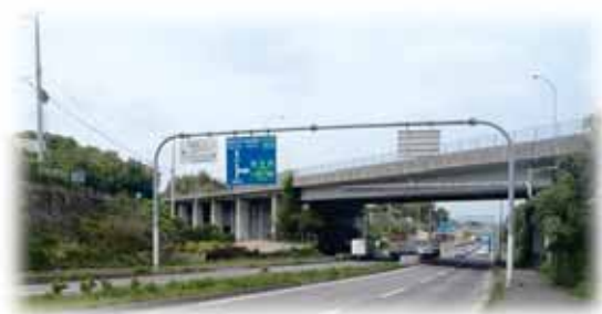
(都) 泉南岩出線 泉南 IC 付近
