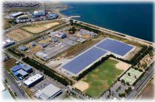
南部水みらいセンター（下水処理場）
