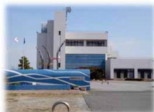
南部水みらいセンター（下水処理場）
