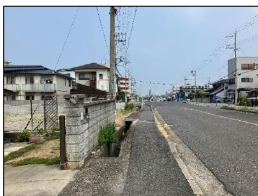
【歩道未改良区間】側溝蓋がない
