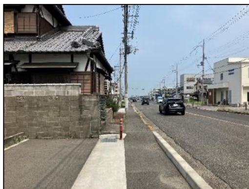
【歩道未改良区間】歩道が狭い
