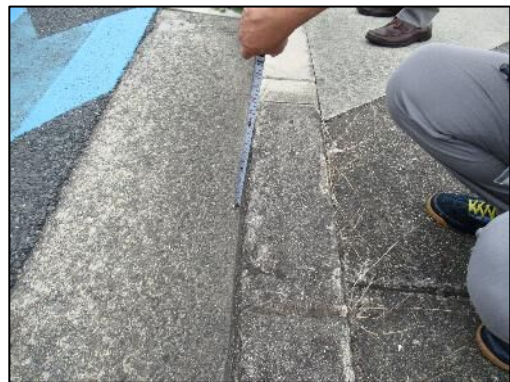
歩道と車道の段差
