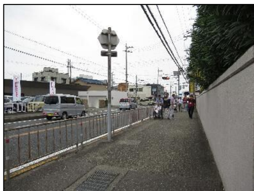
アスファルト舗装
