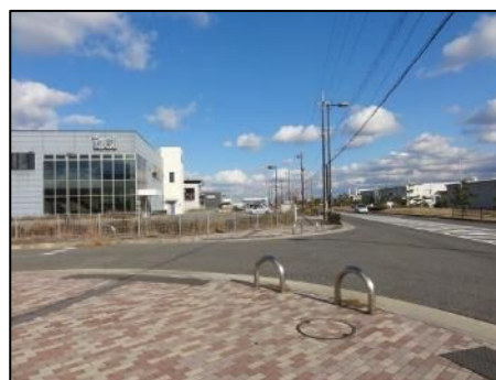
横断歩道が設置されていない箇所
