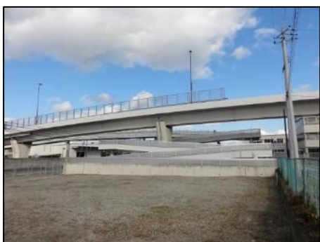
南海跨線橋のスロープ
