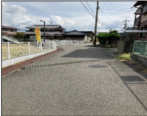
グレーチングの網目が粗い
