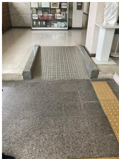
スロープ設置
