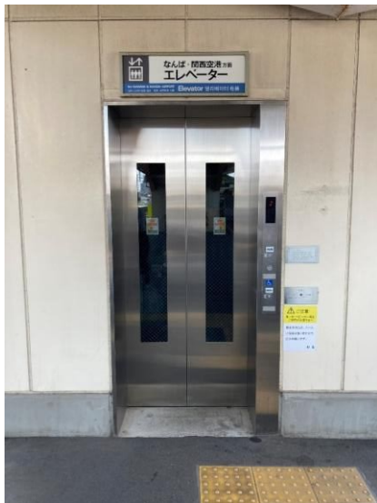
エレベーター設置
