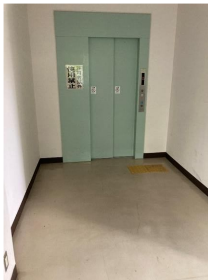
エレベーター設置
