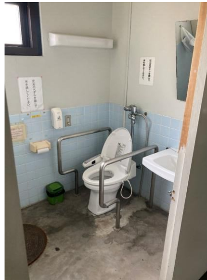
車いす対応トイレ
