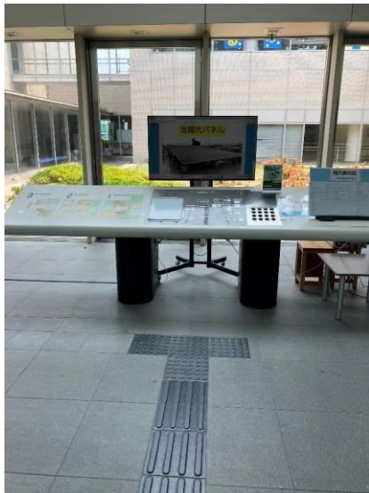
誘導ブロック・情報装置
