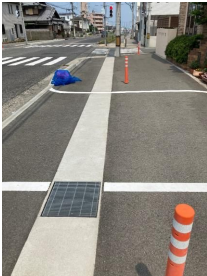
歩道の拡幅整備
