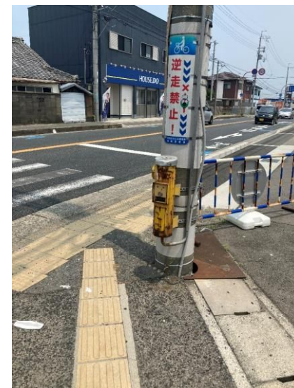
誘導ブロック改修（未整備）
