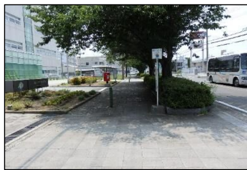
誘導用ブロックが設置されていない
