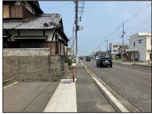
【歩道未改良区間】歩道が狭い
