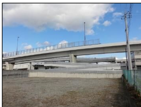
南海跨線橋のスロープ
