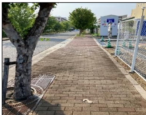
誘導用ブロックの連続性がない
