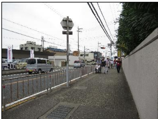
アスファルト舗装
