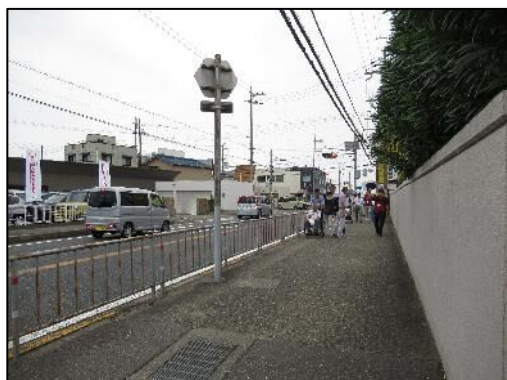
アスファルト舗装
