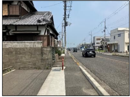
【歩道未改良区間】歩道が狭い
