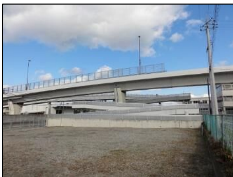
南海跨線橋のスロープ
