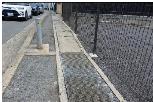
歩道の車止めが障害となっている
