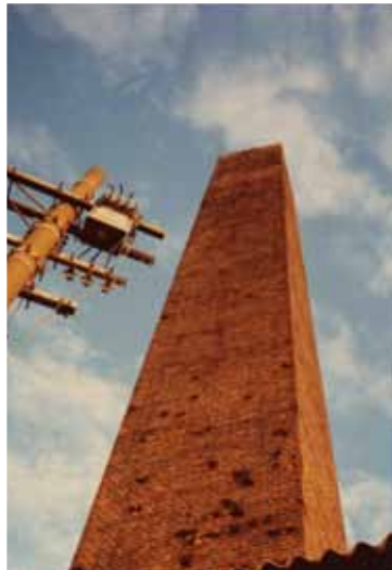
写真7 三和煉瓦製造所の煙突 黒い穴が機銃掃射の痕跡
