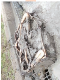
② 高圧洗浄機を使って根を掘り出しました
