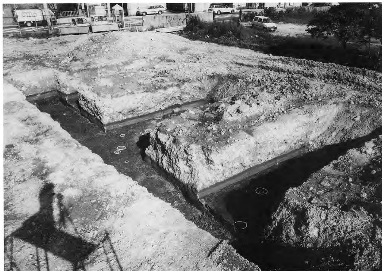
第1トレンチ全景（西から）
