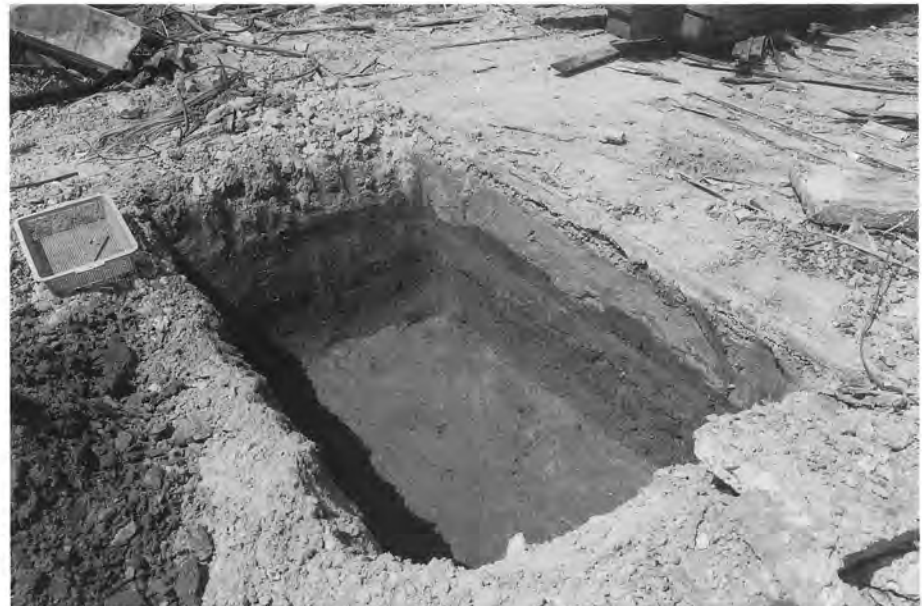
OKD02-3区 第1トレンチ (南西から)
