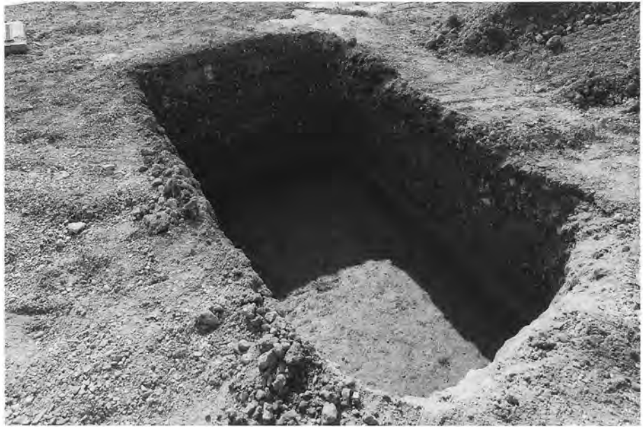
ON02-1区 第2トレンチ (北から)
