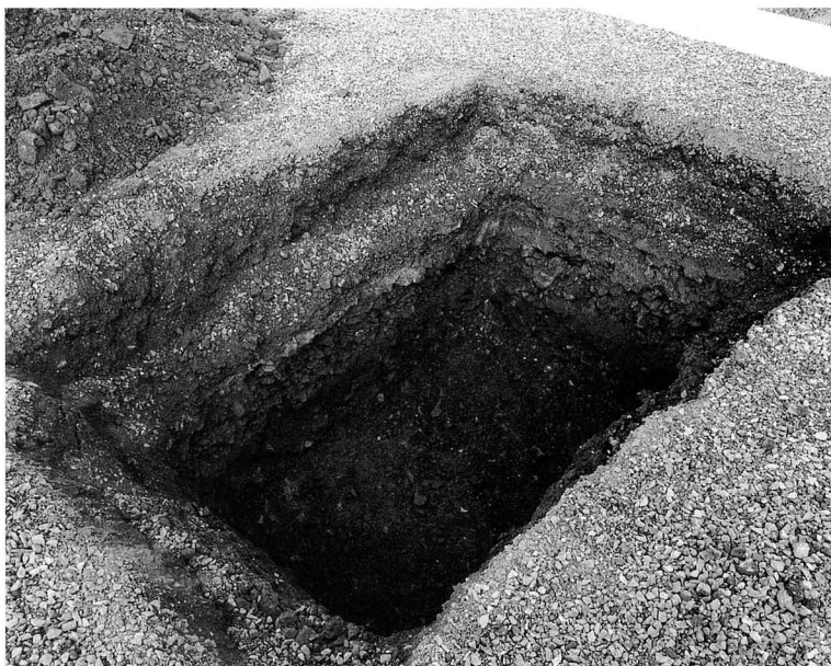
ON03-8区 (北東から)
