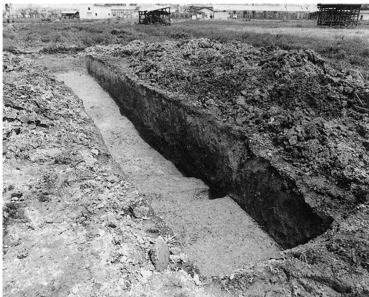
ON06-7区 第2トレンチ (南西から)
