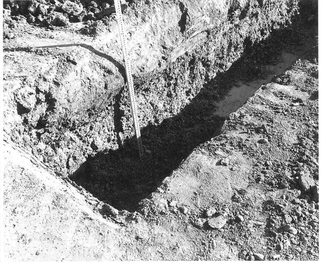
試掘調査No. 1区
