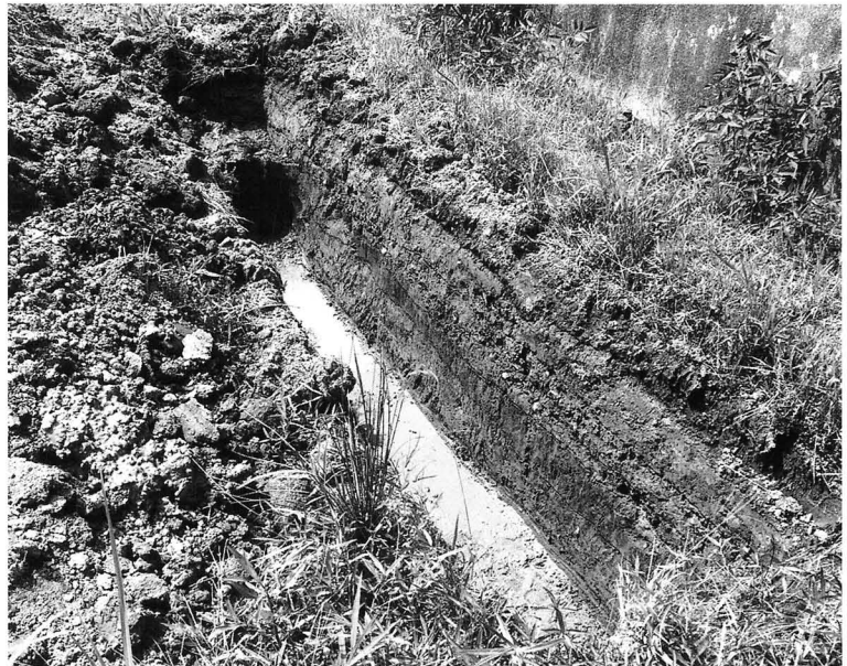
第5トレンチ (南西から)
