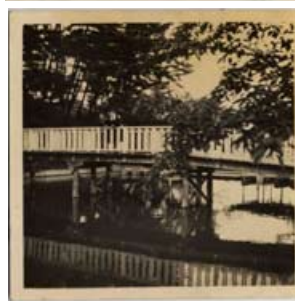
191007 砂川遊園地のボート池
