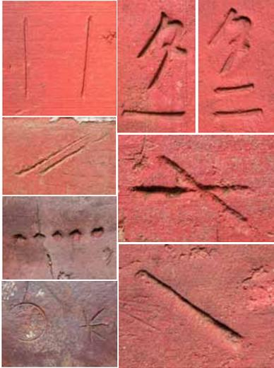
な板の動いた跡がみられます。底のないタイプの型に粘土を詰め、その後、「針金で粘土を削り落とす」ためです。「へっついさん」に使うものは、全面型仕上げ。外側になる面だけに釉がかかり、上下面に布目が見られます。原料となる粘土は、「長山あたり」から牛が引く荷車で運んでいた覚えがあるとのこと。レンガを焼くのは「のぼり窯」。トンネル状で長さは30mほど。内部はちょうど「かくれんぼにぴったり」の大きさ。燃料は赤松で、工場敷地に「山積みされていた」とか。レンガは窯で「3日間焼き続ける」ため、「薪割り職人さん」がいたそうです。樽井煉瓦製造所では瓦を作ることもあり、「西園寺公望の別邸建築に使われた」とか。そう聞くとレンガはどこで使われたのかが気になる。船で安治川の港(大阪市大正区)まで運んだ。その先は不明とのこと。
