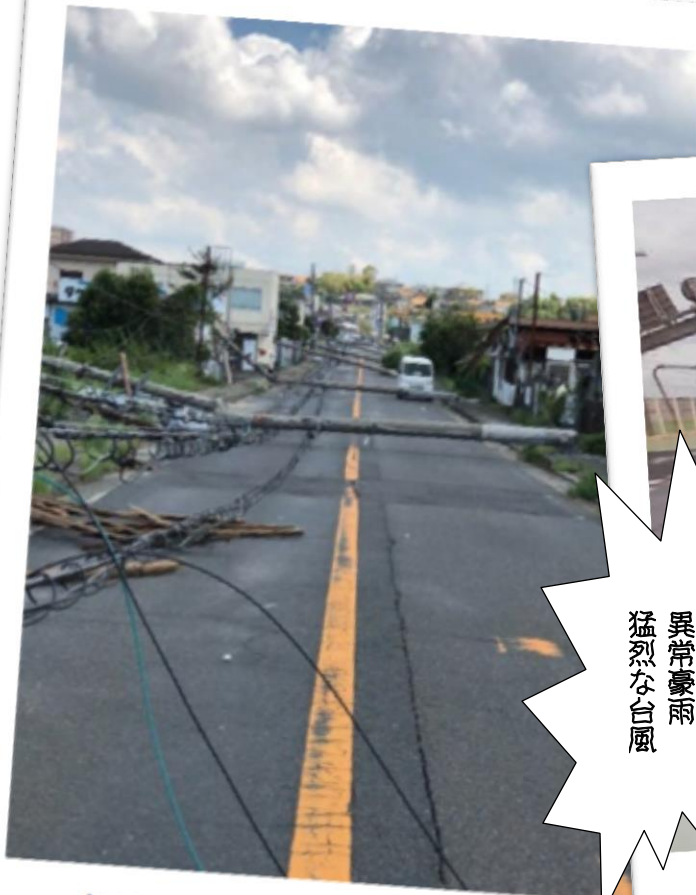
台風第21号による電柱倒壊 (大阪府泉南市)
