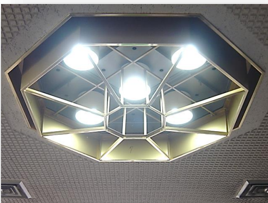
エントランス照明の改良 令和 2年 9月
