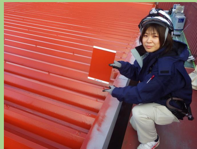
現場確認の様子
