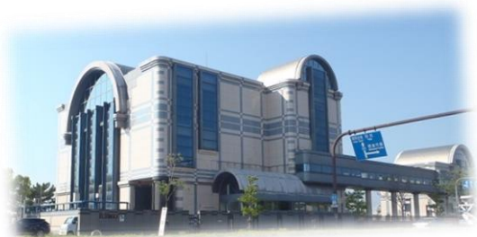
中部ポンプ場(雨水ポンプ施設)
